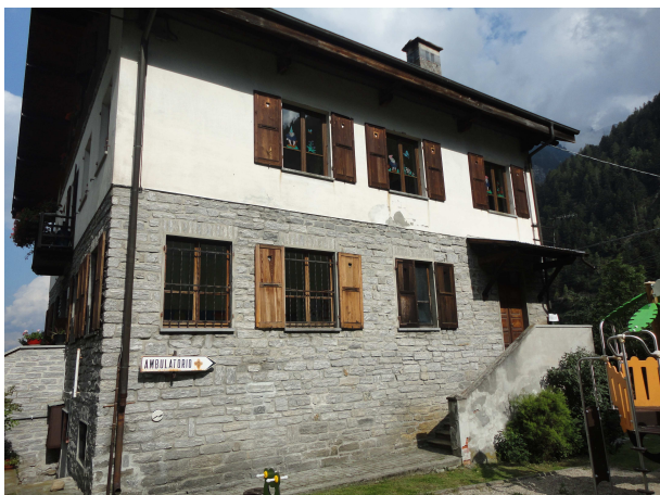
Foto 3 Scuola elementare Italo Hor (prospetto ovest)
