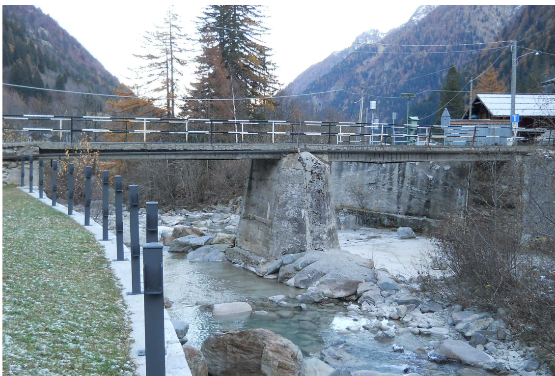
Vista del ponte esistente da monte
