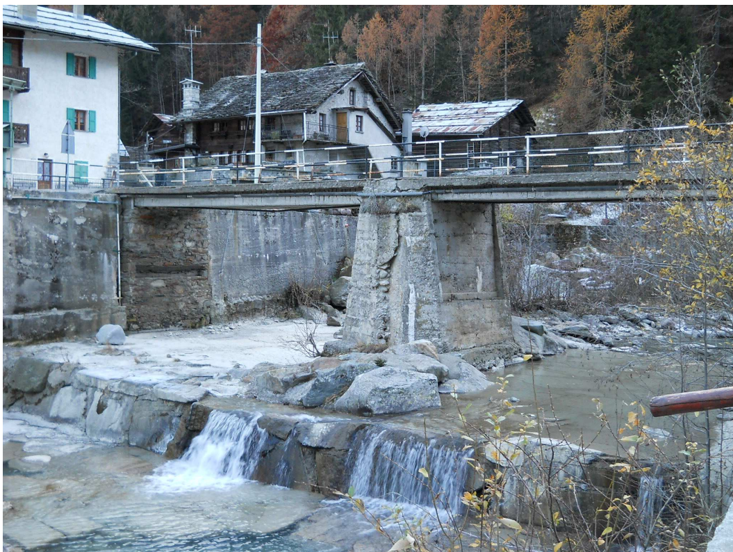
Vista del ponte esistente da valle
